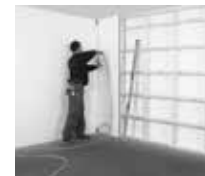
Bevestigen in hoek dwars door paneel (op 10 mm van de paneelrand).
